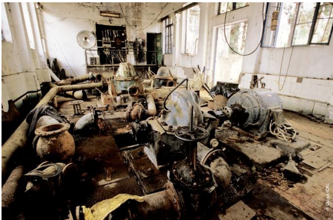
Фотография 4. Демонтаж функционирующего оборудования с менее важной части системы и его установка на более важной части той же системы как решение проблемы в чрезвычайной ситуации может в долгосрочной перспективе создать отрицательные последствия, устранить которые будет гораздо более проблематично. (Грузия, 2003 г.)
