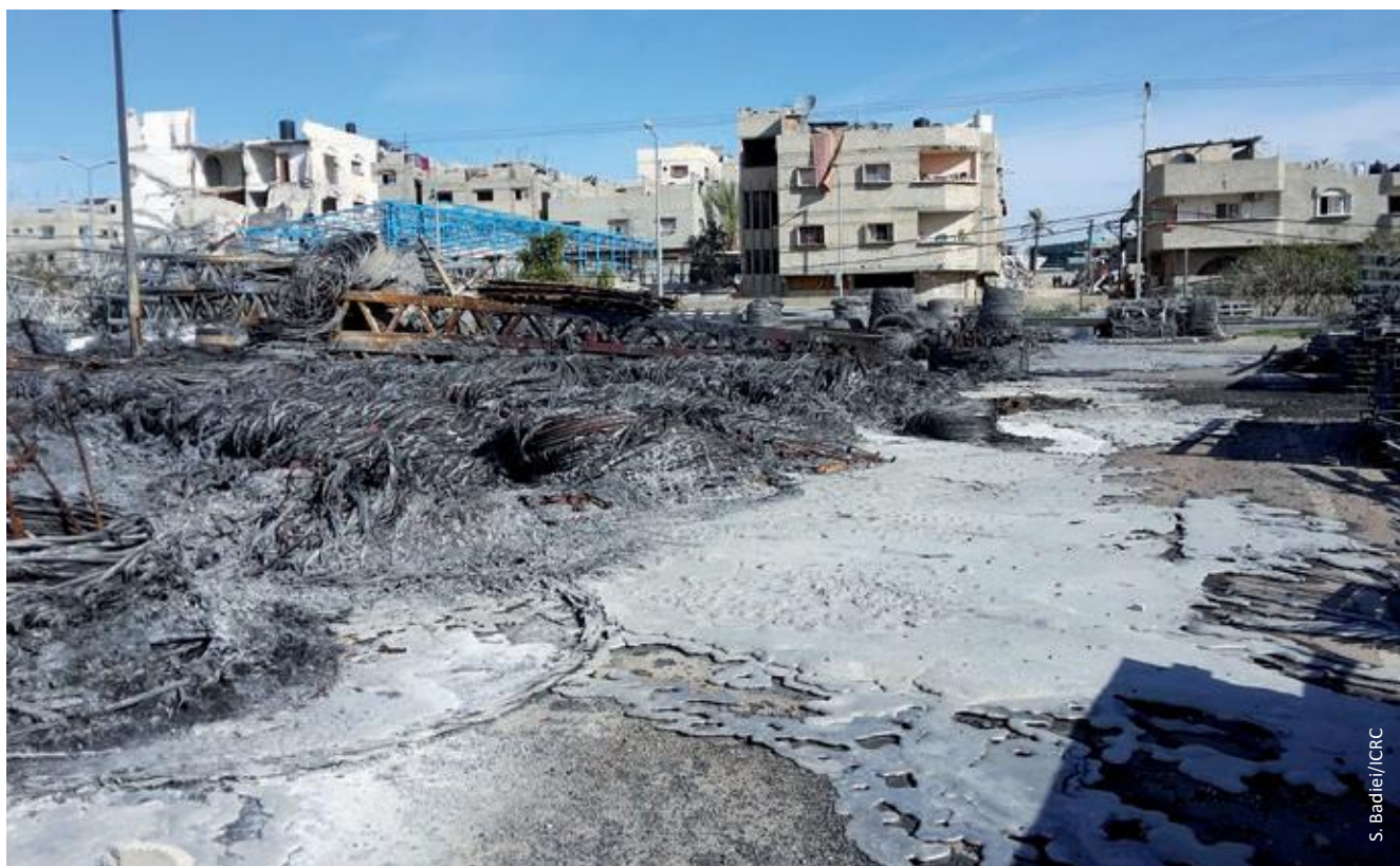
Фотография 5. Расплавление проводов и столбов в результате разрушения склада энергетической компании в секторе Газа в 2014 г., вследствие чего компания потеряла возможность устранять поломки. Необходимый ремонт электросети проводился за счет демонтажа такого оборудования, как трансформаторы, провода и столбы, в менее критически важных местах и их установки в более критически важных местах (например, в больницах) (сектор Газа, 2014 г.)
