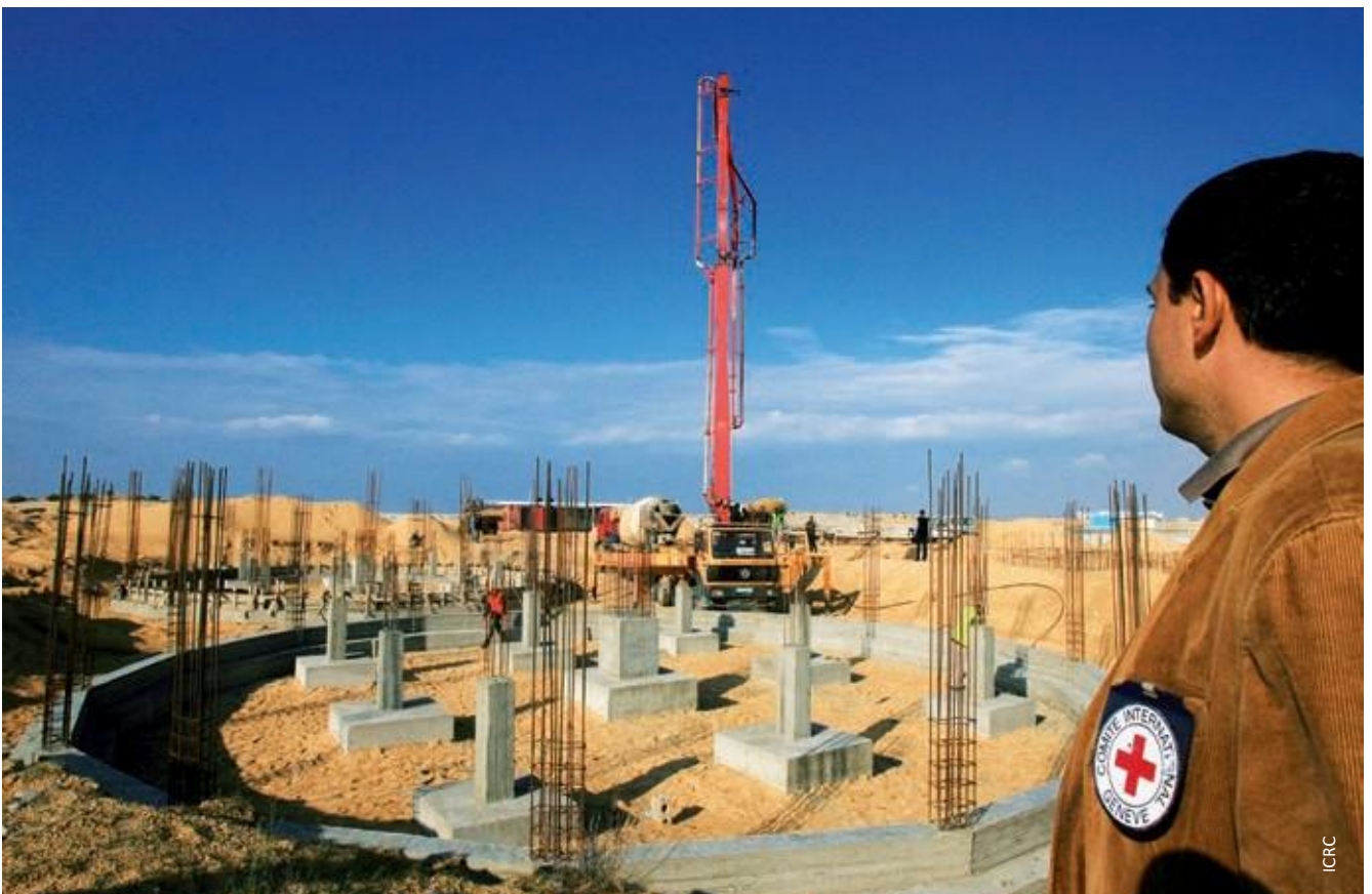
Фотография 9. Надзор за строительством местным подрядчиком станции очистки сточных вод в г. Рафах, обслуживающей 150 000 жителей (сектор Газа, 2009 г.)
