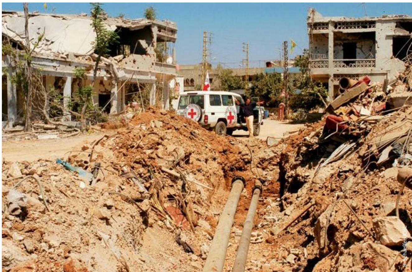
Фотография 3. Начинаются накапливаться последствия прямого и косвенного воздействия. Эти трубы можно отремонтировать, но если напор воды будет недостаточным, местные жители, скорее всего, установят несанкционированные насосы («отрицательный» механизм преодоления кризисной ситуации), которые могут загрязнить воду в общей водопроводной сети и подвергнуть риску здоровье многих людей (Южный Ливан, 2006 г.)
